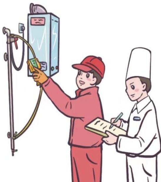
3. 应定期对气瓶、燃气具、连接软管等进行检查，保证各连接处连接紧固，无缺陷。可使用发泡剂（肥皂水、洗洁精水等）的方法对所有连接处进行检漏，严禁使用明火查漏。
